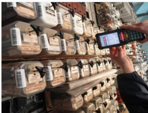
Рисунок 1 – Учет аппаратуры ЖАТ с применением КПК и технологии штрих-кодирования.
