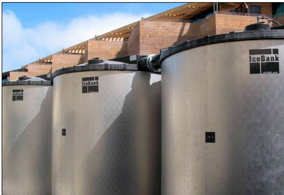
Рисунок 5 – Накопитель холода Калифорнийской компании «Ice Energy»
