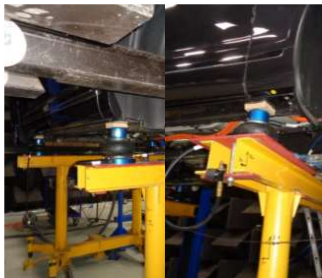
Рисунок 12. - Установка зеленого кузова на пневмопоры.
