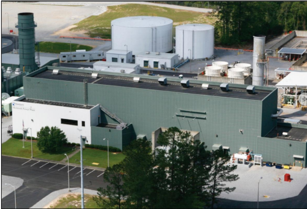
Рисунок 3 – Неадиабатическая установка сжатого воздуха мощностью 110 МВт в Макинтоше, Алабама
