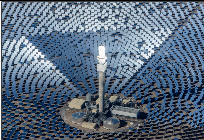
Рисунок 6 – Башня с расплавленной солью и зеркала, направляющие солнечные лучи к вершине башни
