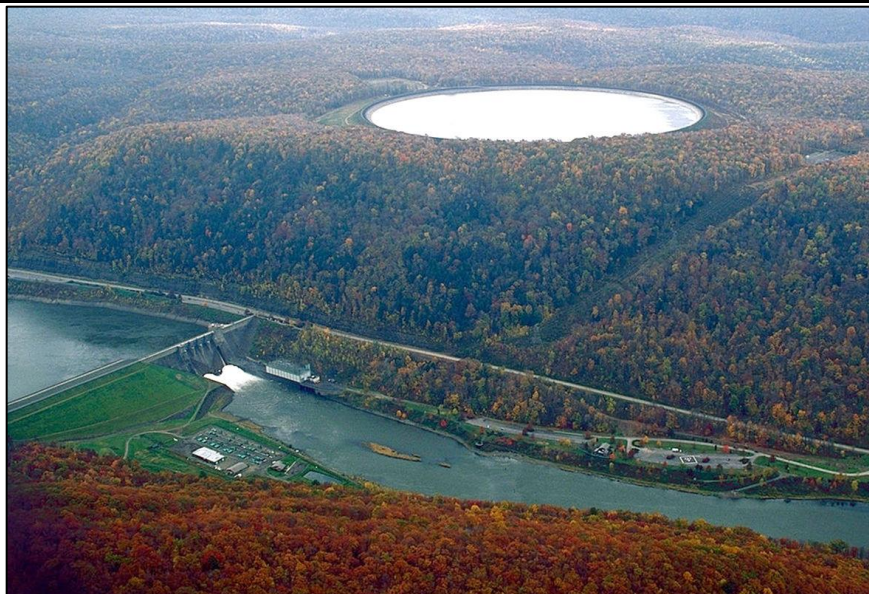
Рисунок 2 – Seneca Pumped Storage Generation Station, гидроэлектростанция в Пенсильвании в графстве Уоррен, использующая гидроаккумуляторы для выработки электроэнергии
