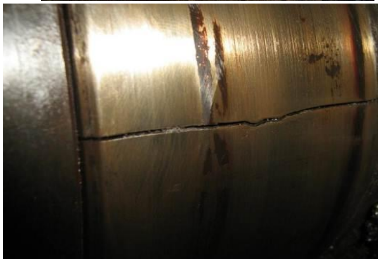
Рисунок 1 – Дефекты в валах агрегатов, обнаруженные при дефектоскопическом контроле
